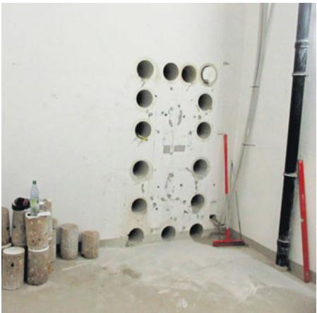
Kernbohrungen im Kryptabereich für den Zugang zur neuen Fluchttreppe. Foto: HJW + Partner
